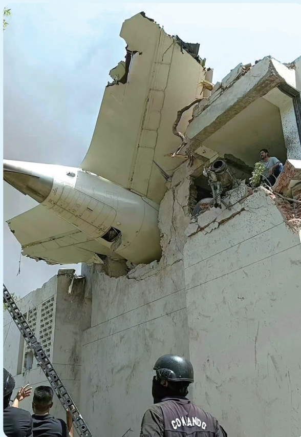
建筑物顶上的客机残骸
